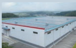
西日本ロジスティクスセンター（兵庫県三木市）内の遊休部分および同センター内建物の一部屋根を利用した太陽光発電を導入し、メガソーラー売電事業を推進
